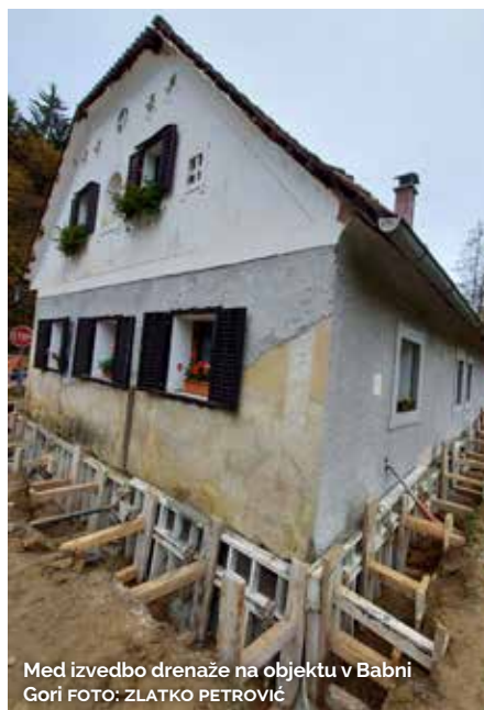
Kakovostna izvedba drenaže na objektu v Babni Gori, ki jo je naredilo gradbeništvo Škorjanec. FOTO: ZLATKO PETROVIČ
